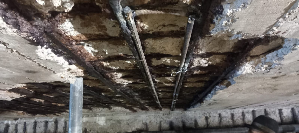
Refuerzos puntuales de las armaduras longitudinales que han sufrido pérdida de sección
