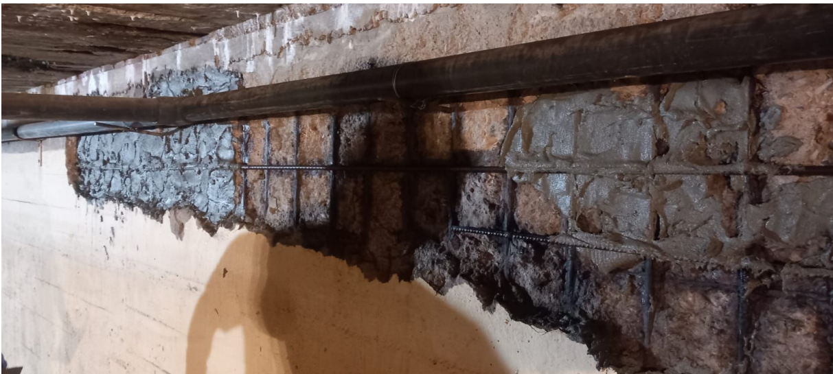
-Aplicación de mortero tixotrópico de alta resistencia en losa y muros perimetrales
